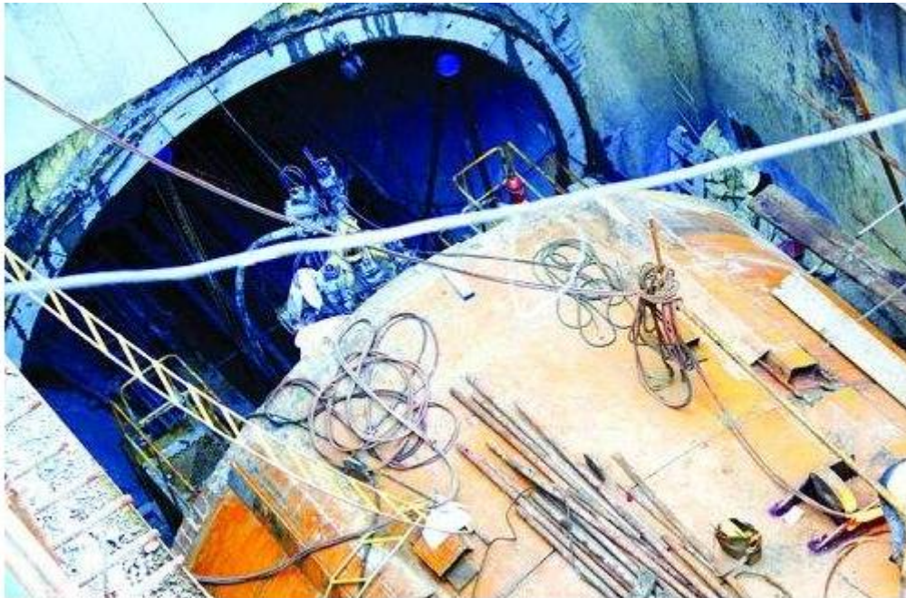
盾构机接收解体
