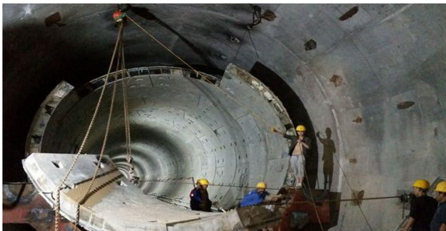
始发阶段施工
