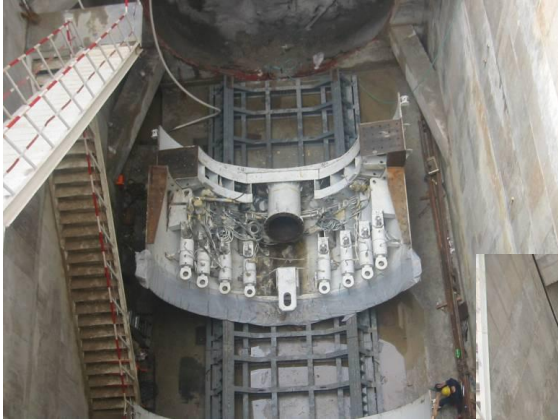
盾构机现场组装图片
