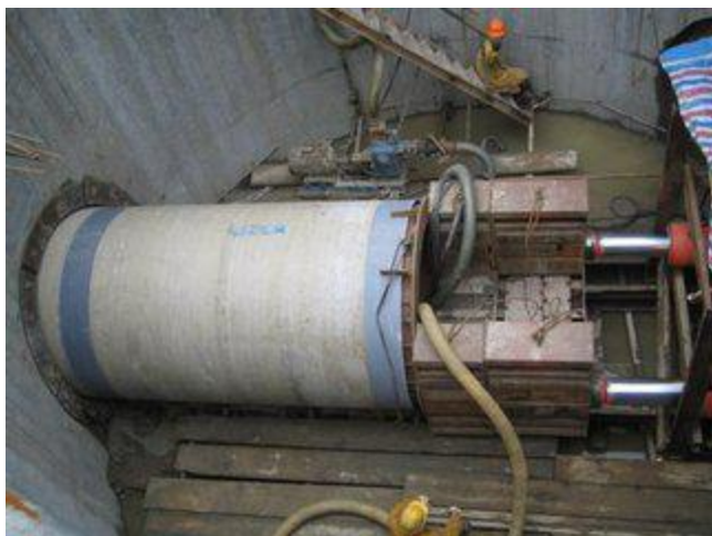
顶管法使用的管
